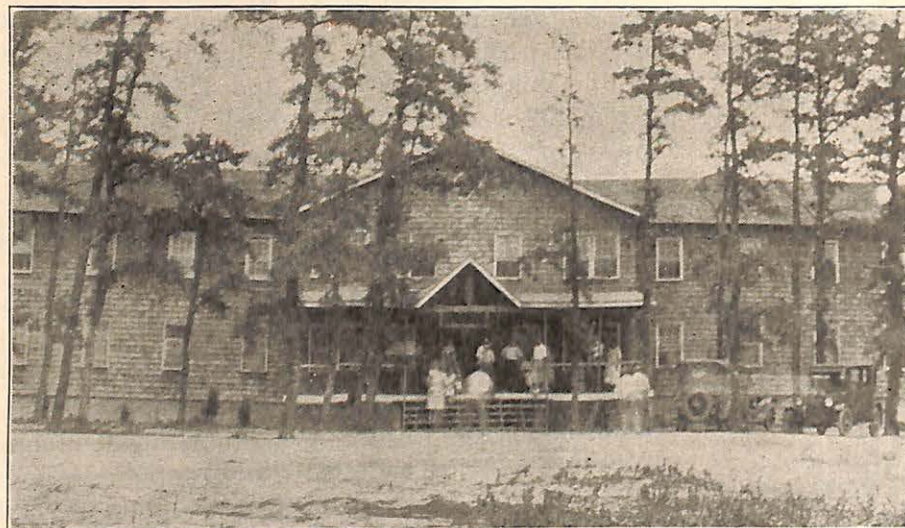
Dormitory, Keswick Grove, N. J.
